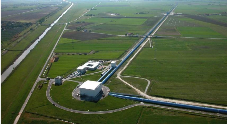
Interferómetro Virgo. Detector de ondas gravitatorias en forma de L construido en Cascina, Italia, en 2003. Colabora con LIGO.
