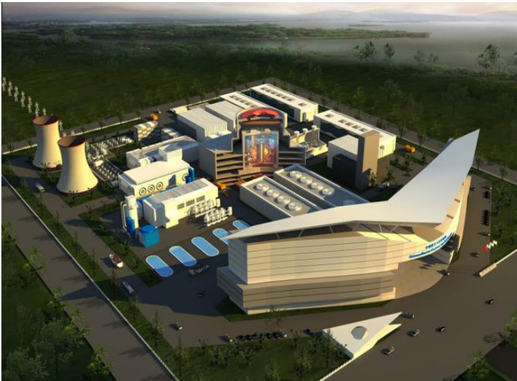
- Reactor CFETR . Reactor de prueba en proyecto. Instituto de Ciencias Físicas. Hefei, Anhui, China.
